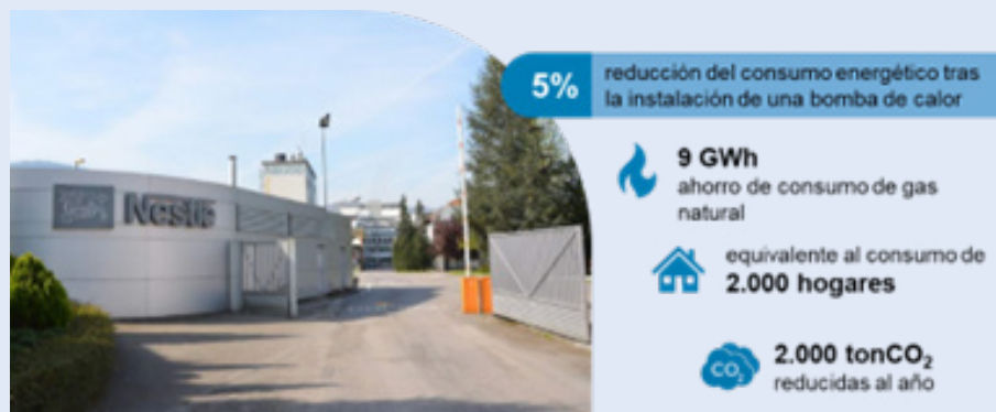
Figura 49. Implementación de bomba de calor en planta de Nestlé, La Penilla de Cayón
